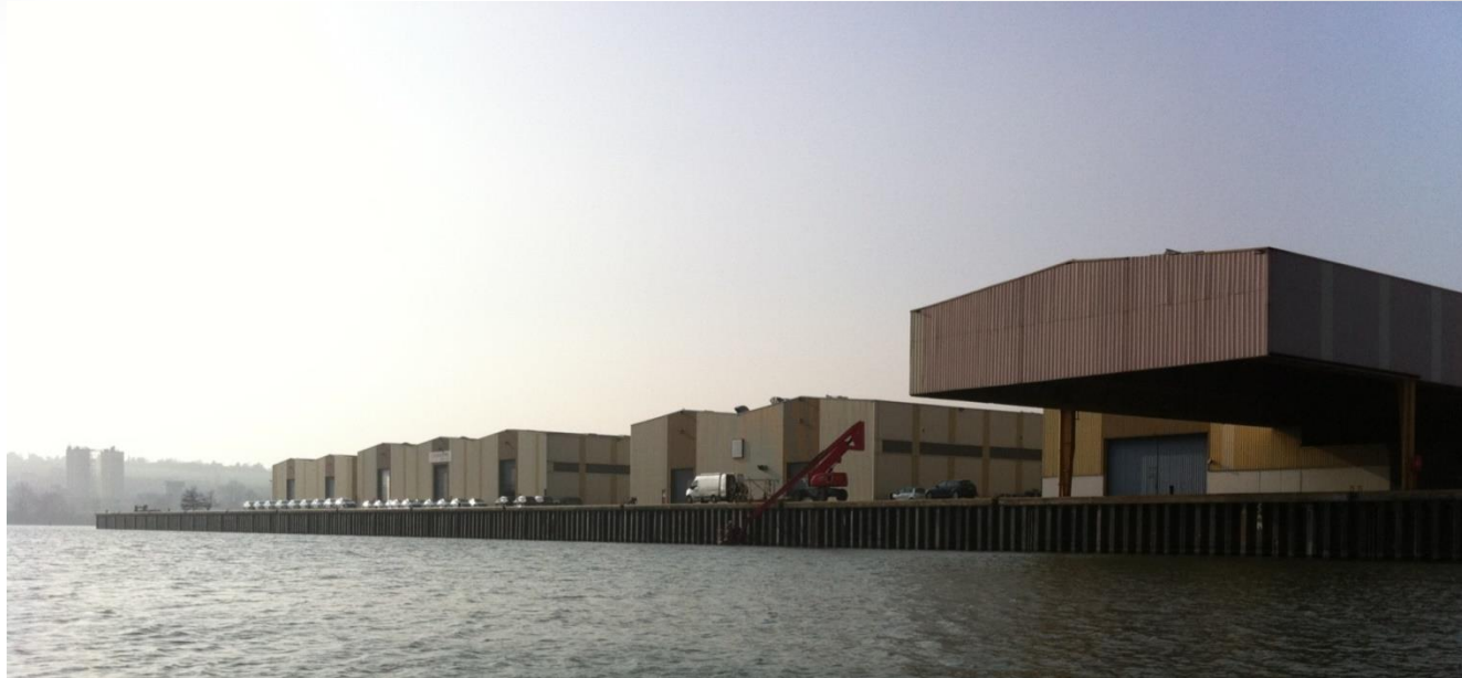
Zone portuaire de Limay Porcheville Réparation de 350 tirants barre P2 Dywidag 32
