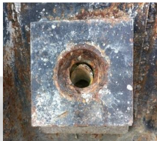
Tête d'ancrage sans protection avec rupture d'armature
