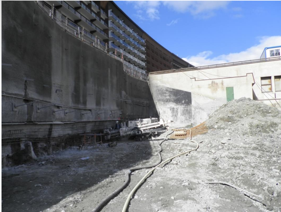
Paroi tirantée, bâtiment Tignes space, Tignes, Savoie , France Tirants gewi 40
