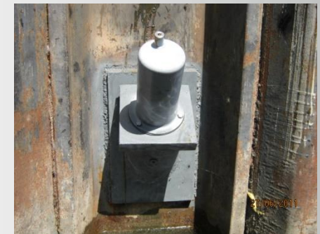
Tête d'ancrage réparée
